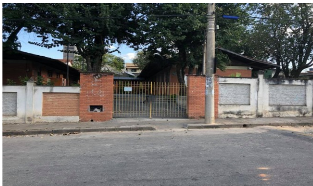
Figura 2 - Fachada principal da escola.
